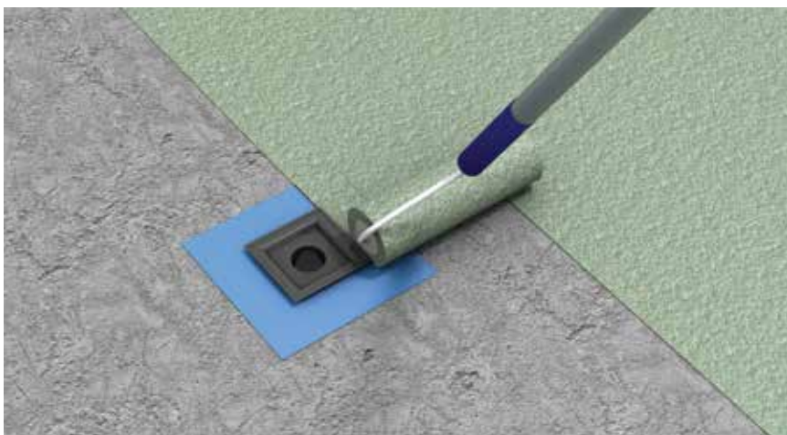
Fig. 2: Aanbrengen van een vloeibare coating met de rol.
